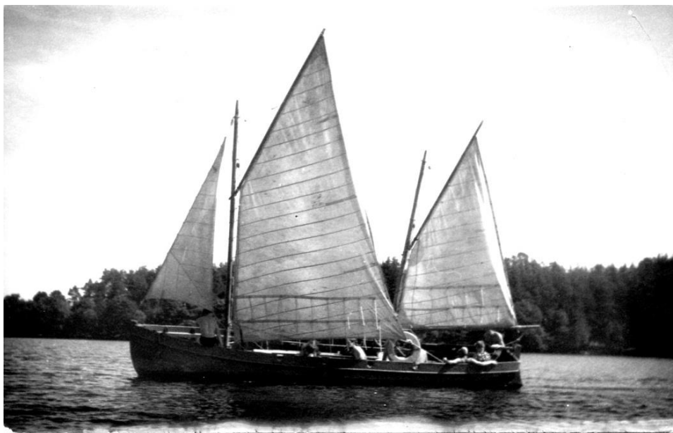
Fot. 5. Obóz żeglarski na Mazurach 1968 r. DZ ( Dezeta, DeZeta, od „Dziesięć Załogi” ) – bezpokładowy jacht mieczowy wiosłowo-żaglowy o ożaglowaniu kecza gaflowego, kadłub z tworzywa sztucznego. Powierzchnia ożaglowania ok. 30 m 2 , maksymalna liczba załogi 12 osób
