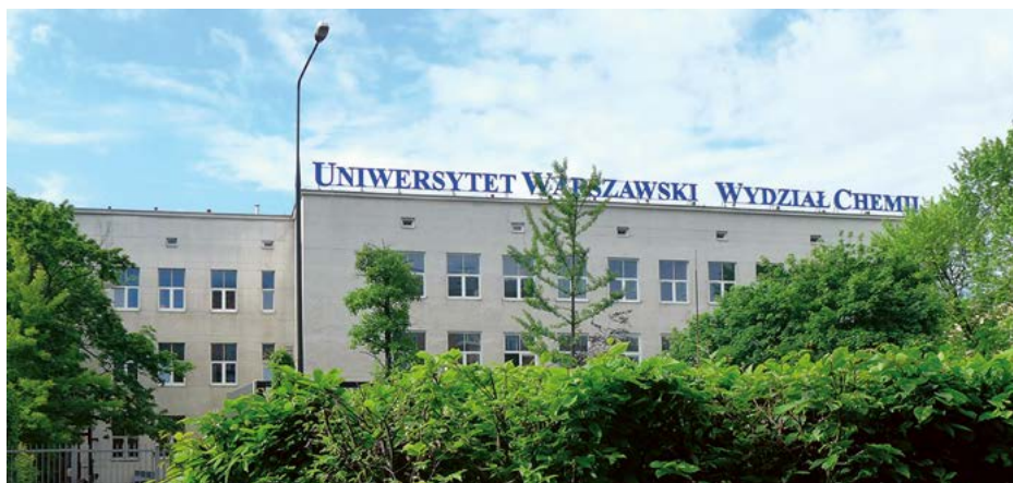
Fot. 9. Gmach Wydziału Chemii UW – widok od ulicy Wawelskiej
