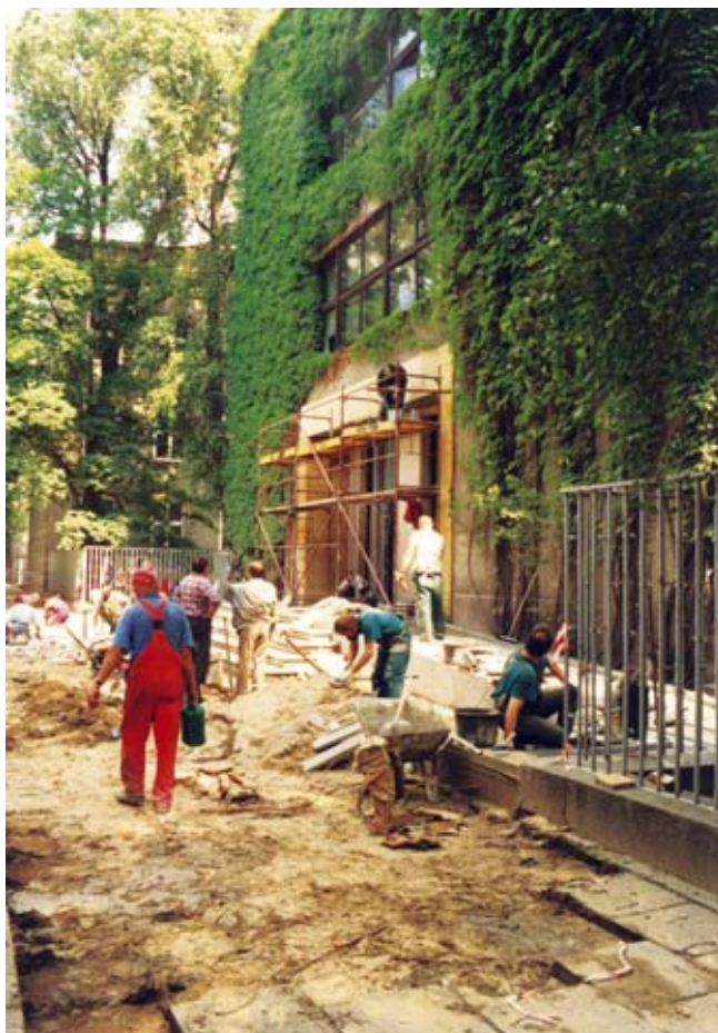
Czerwiec 2000. Przebudowa wejścia do Gmachu Chemii
