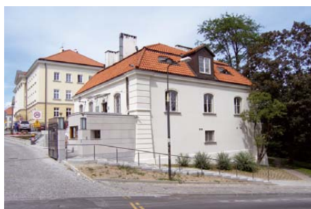
Współczesny widok odbudowanych fragmentów dawnego pawilonu chemicznego
