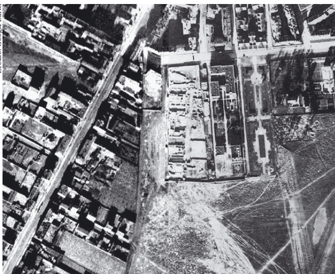
Listopad 1935 r. Plac budowy gmachu chemii widziany z góry.
